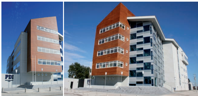
Figura 2.2. Edificio PDI de Puerto Montt, que posee una envolvente térmica mejorada. (Fotografía DA MOP Región de Los Lagos)
