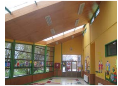
Figura 3.1. Captación de radiación solar en Edificio Escuela Gabriela Mistral, Aysén (Zona 8 SE)
