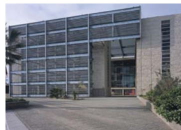
Figura 1. Edificio Secretaría Ministerial de Obras Públicas, Antofagasta, Región de Antofagasta. Con EE.
