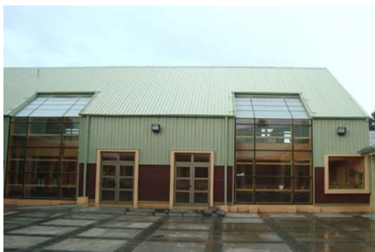
Figura 3.6. Captación solar directa en fachada norte, Escuela Teniente Merino, Cochrane (zona 8 SE)
