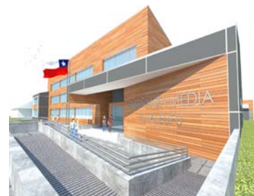
Figura 3.5. Captación solar directa a través de ventanas orientadas al norte. Proyecto Escuela de Futaleufú (zona 8 SE) (Cristián Sanhueza, arqts.)
