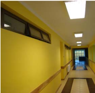
Figura 4.5. El edificio Escuela Teniente Merino, Cochrane Región de Aysén incluye estrategias de ventilación natural cruzada considerando ventanas proyectantes entre las aulas y los pasillos.
