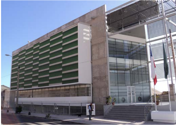
Figura 4.18. Edificio Labocar de Antofagasta (zona 1 NL). Protecciones solares controlan la radiación solar sobre muros de hormigón armado
