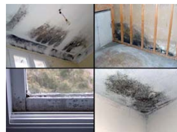
Figura 2.31. Efectos indeseados típicos de puentes térmicos.
