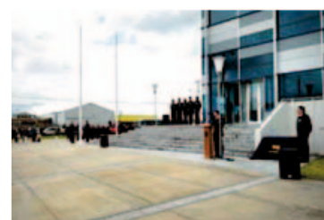
Figura 1.23. Acceso edificio de Oficinas Policía de Investigaciones, Puerto Montt Décima Región de los Lagos.
