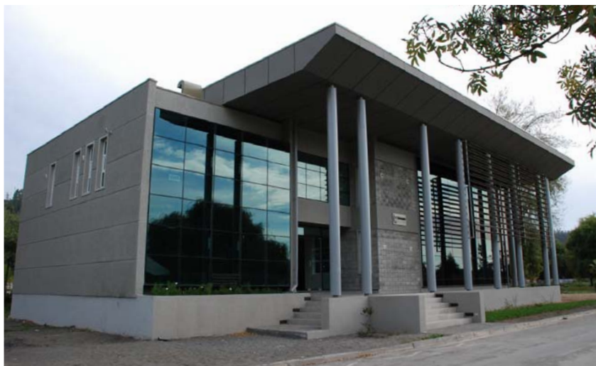
Figura 3.13. Muro Trombe CITEC UBB, Concepción (zona 6SL)
