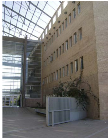
Figura 4.17. Muros con alta masa térmica en edificio MOP de Copiapó (zona 3 NVT). Se puede observar el predominio del lleno sobre el vano y las materialidades de hormigón y enchape de ladrillo, que logran una alta masa térmica.
