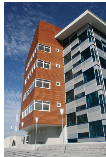
Figura 2.70. Edificio de Oficinas Policía de Investigaciones, Puerto Montt (Zona SL)
