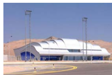
Figura 3. Edificio Terminal de Pasajeros, Desierto de Atacama, Región de Atacama. Con EE.
