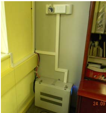
Figura 17. Monitorización de variables ambientales higrotérmicas. Oficina de Dirección, MOP Puerto Montt.
