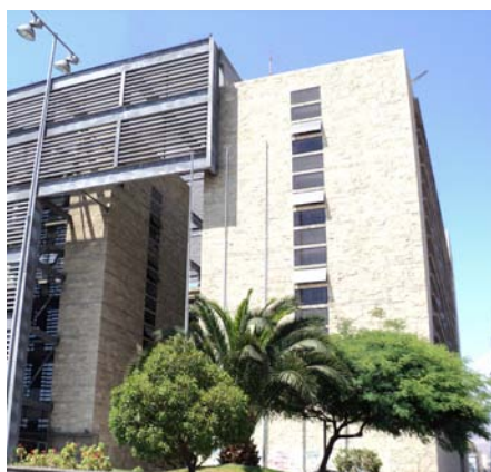
Figura 3.18. Muro con masa térmica, edificio MOP Antofagasta (zona 1 SL)
