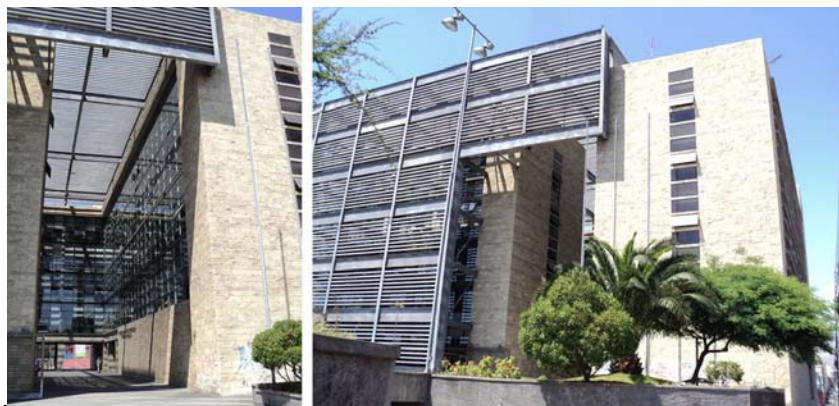
Figura 1.21. Protección de fachada sur-poniente, nor-orienté y patio interior con pantalla de acero galvanizado. Factor de sombra 37%
